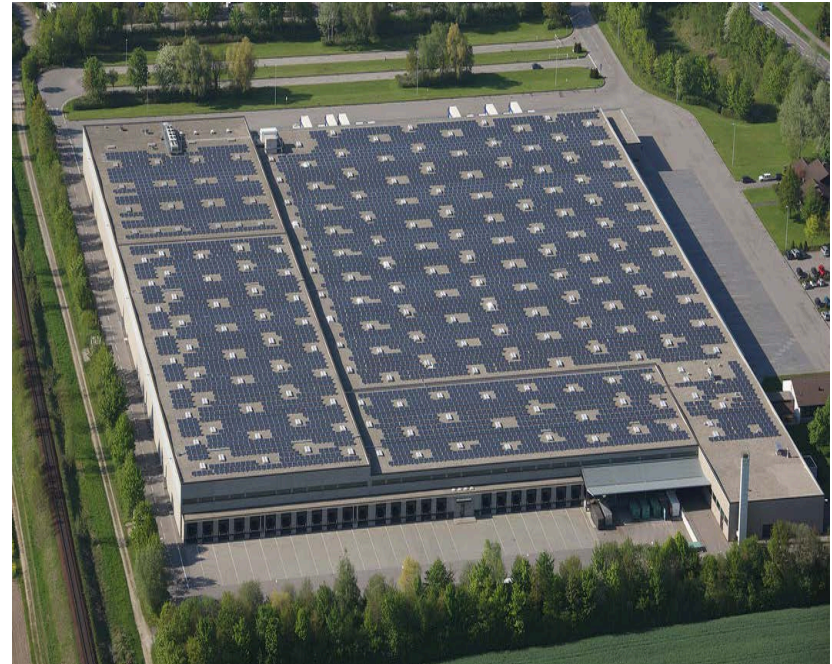
Bild © Pohlen-Solar: PV Kraftwerk mit 1500 KWp in Altenstadt
