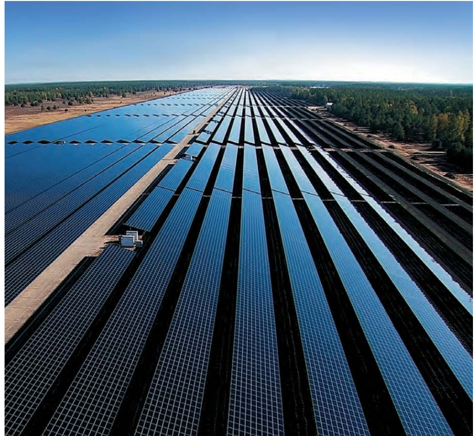
Bild © Commerzreal: PV Kraftwerk mit 128 MW in Templin
